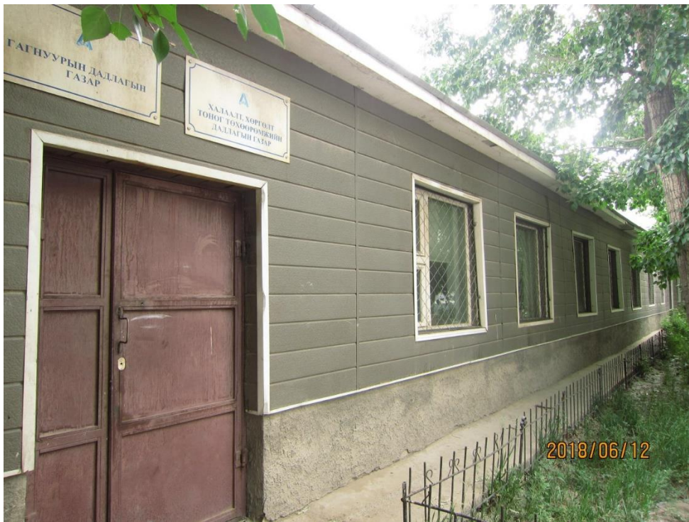
PICTURE 1. WORKSHOP /To be demolished/ ЗУРАГ 1. ҮГТ – Дадлагын байр /Буулгана/
