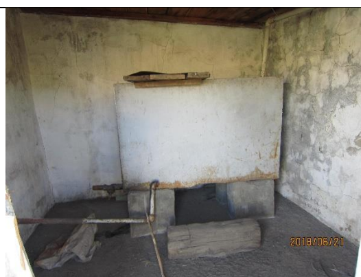
Pic 1.2 Inside of water well building #1 Гүний худгийн барилгын доторх байдал
