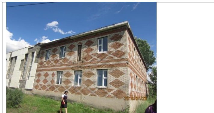
Pic 2.1 Workshop for rehabilitation / Засвар хийх дадлагын байр
