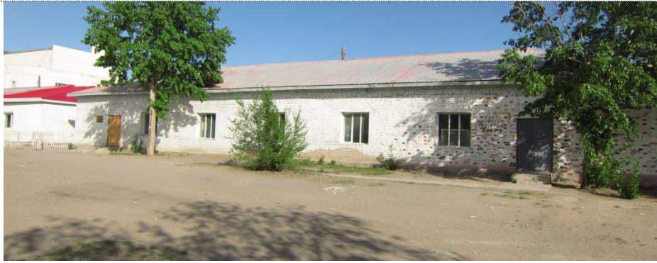
Pic 1.2 Construction sector workshop building No2 / Барилгын мэргэжлийн дадлагын 2-р байр
