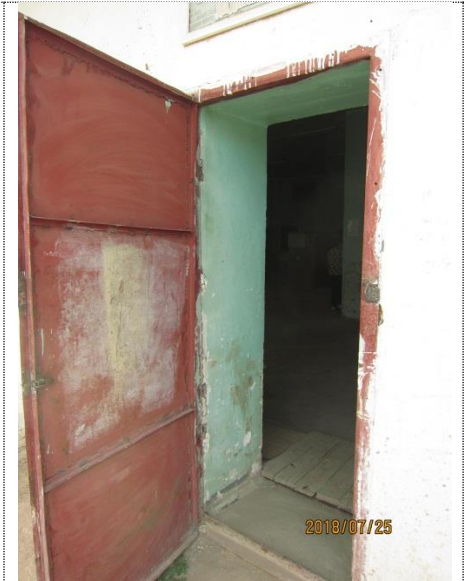
Pic 1.2 Drywall finisher workshop / Хуурай хийцийн дадлагын өрөө
