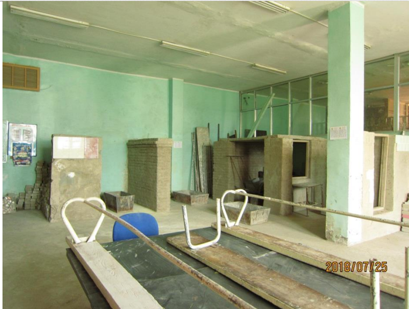
Pic 1.1 Drywall finisher workshop / Хуурай хийцийн дадлагын өрөө
