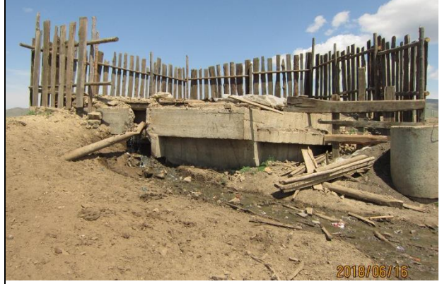
Pic 1.4 Temporary protective fencing around the sewage pit / Цэвэрлэх байгууламжийн түр хашлага 2018.06.16
