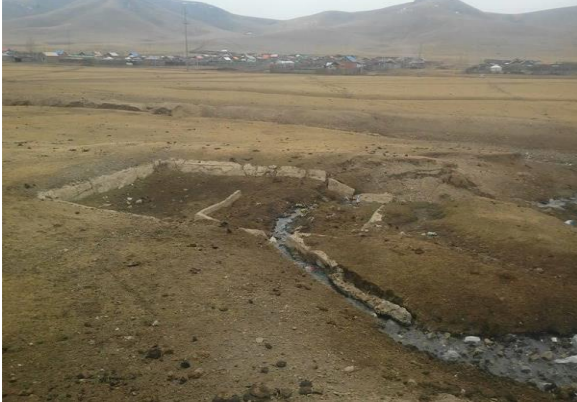
Pic 1.3 Sewage facility, a protective shield was damaged by strong wind, so it was demolished / Цэвэрлэх байгууламжийн дээрх хамгаалалт салхинаар нурсан тул буулгасан 2018.06.03
