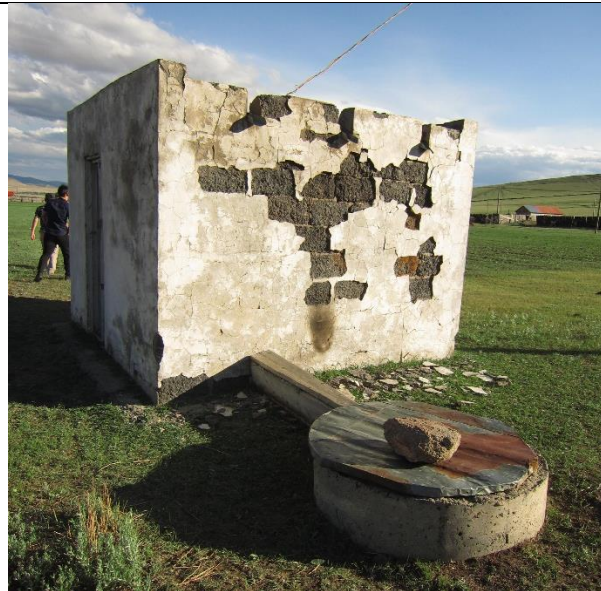
Pic 1. 1 Water well #1 Гүний худгийн барилга
