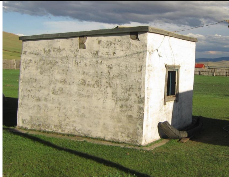
Pic 1. 3 Water well #2 Гүний худгийн барилга
