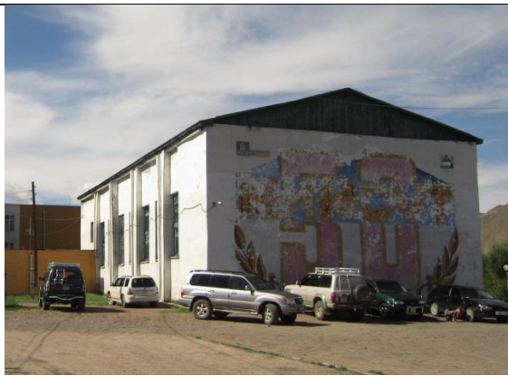
Pic 1.7 Sport hall building / Биеийн тамирын заалны барилга
