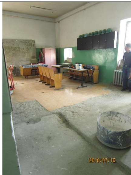
Pic 1.4 Interior finisher shop / Барилгын засал чимэглэлийн дадлагын байр
