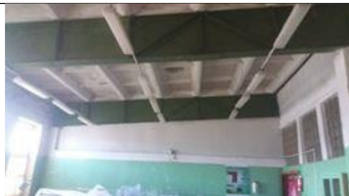
Pic 1.1 Interior finisher shop / Барилгын засал чимэглэлийн дадлагын байр
