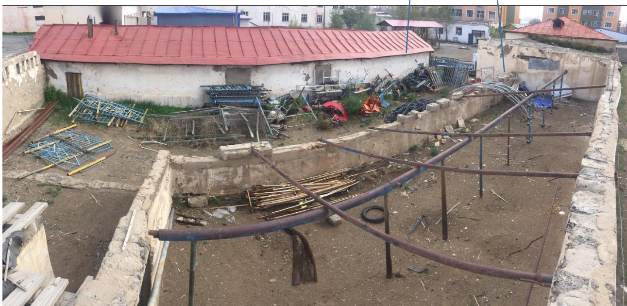
Pic 1.2 Greenhouse remains / Хүлэмжийн үлдэгдэл
