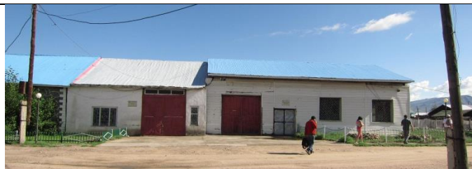
Pic 1.3 Auto body repair shop and Auto mechanical shop / Кузов засварын анги болон Авто засварын анги
