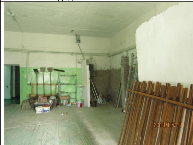
Pic 1.3 Interior finisher shop / Барилгын засал чимэглэлийн дадлагын анги
