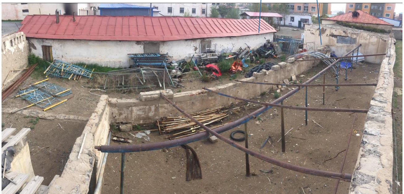
Pic 1.2 Greenhouse remains / Хүлэмжийн үлдэгдэл
