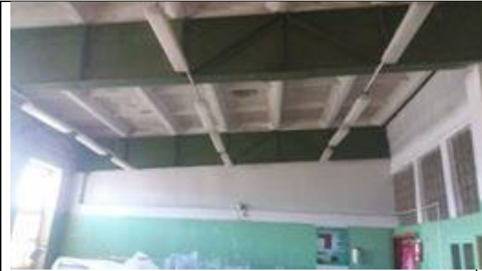
Pic 1.1 Interior finisher shop / Барилгын засал чимэглэлийн дадлагын анги
