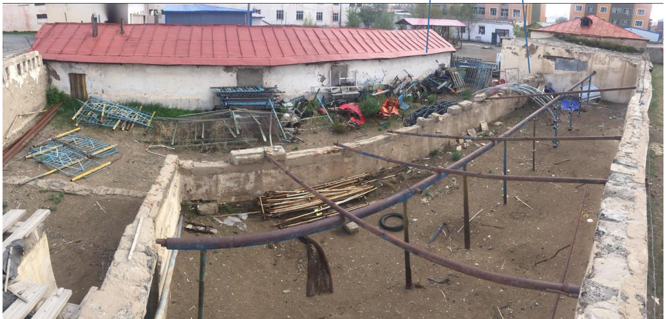
Pic 1.2 Greenhouse remains / Хүлэмжийн үлдэгдэл
