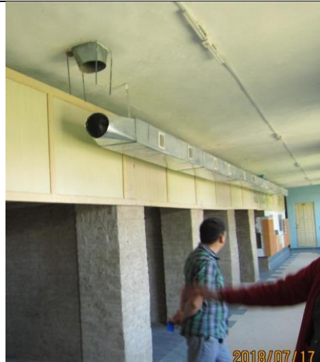
Pic 1.6 Ventilation system Салхивчийн шугам /одоо байгаа/
