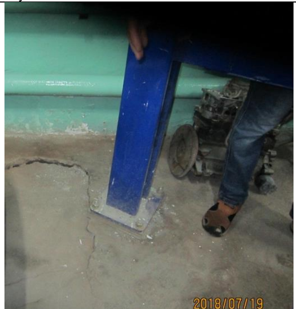
Pic 1.4 The footprint of one pole of the existing 4 post car lifter / 4 тулгууртай авто өргөгчийн нэг тулгуурын доорх эвдэрсэн шал
