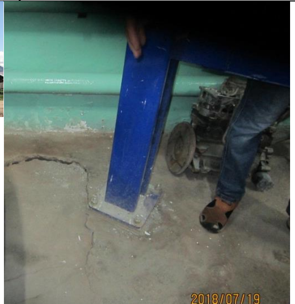
Pic 1.4 The footprint of one pole of the existing 4 post car lifter / 4 баганатай авто өргөгчийн нэг тулгуурын доорх эвдэрсэн шал / суурь
