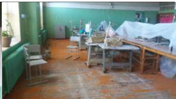
Pic 1.2 Interior finisher shop / Барилгын засал чимэглэлийн дадлагын анги
