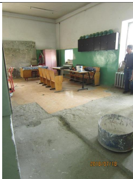
Pic 1.4 Interior finisher shop / Барилгын засал чимэглэлийн дадлагын анги
